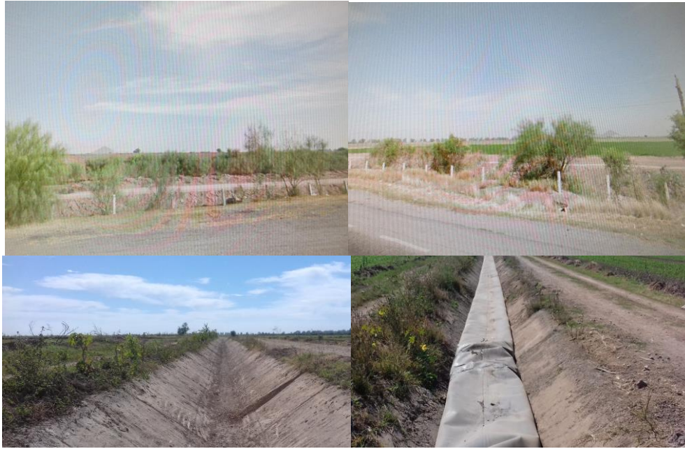
Figure 3b. Above: Panoramic views of Juan José Ríos region; Below: Distrito de Riego 063, both in the Municipality Guasave, Sinaloa, México ( http://www.riegosydrenaje.com.mx/geomembrana/experiencias-en-el-geomembranizado-de-canales-en-el-distrito-de-riego-063-en-guasave-sinaloa/ ), and Google Maps. Accessed: Diciembre 14, 2019). Contact zone of four species of Leopard frog: R. adleri , R. cora , R. forreri , and R. magnaocularis .
